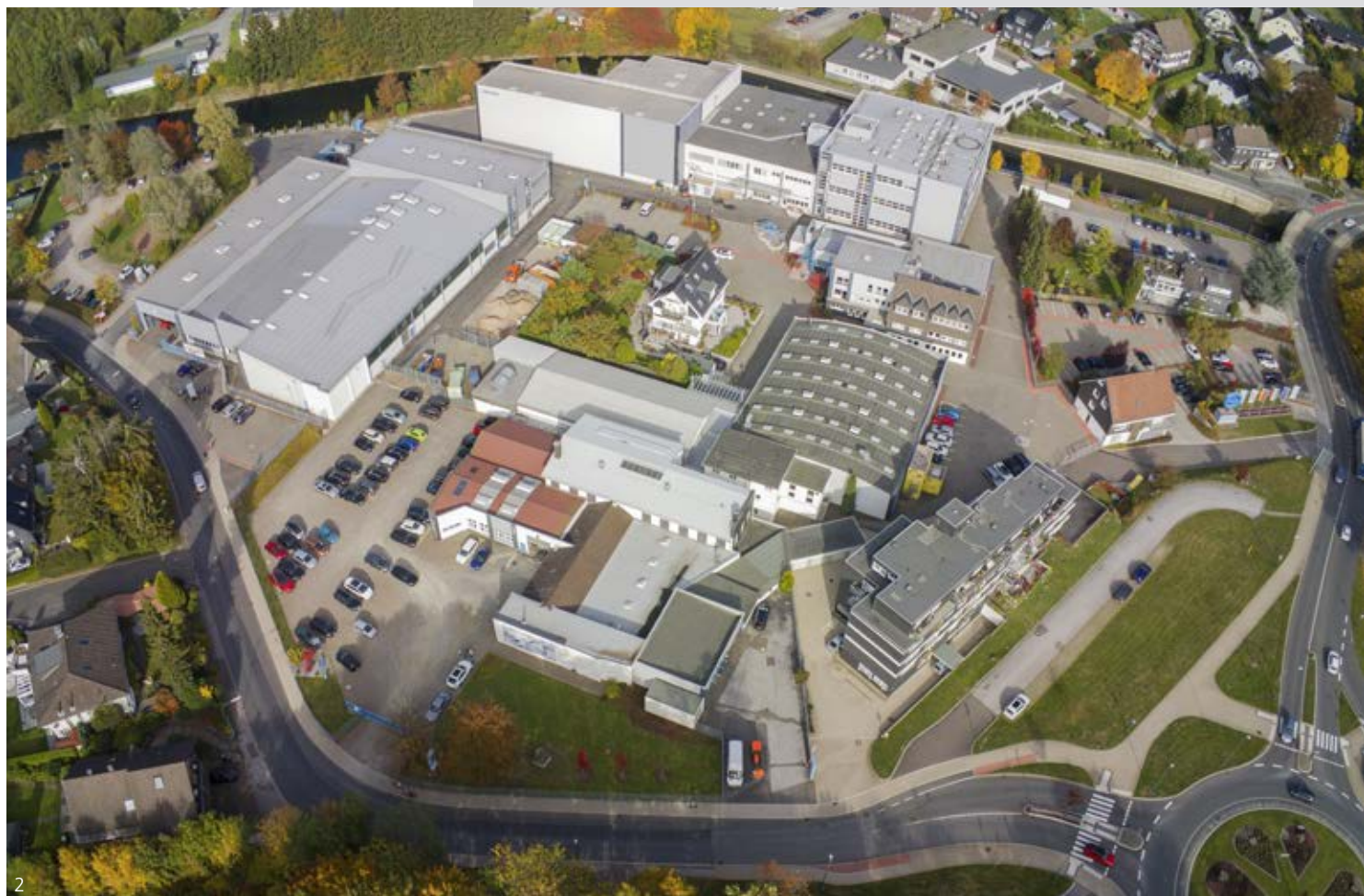
Abb. 1 – Werk 2 – PFLITSCH-Kompetenzzentrum für Kabelkanäle Fig. 1 – Plant 2 – PFLITSCH competence centre for cable trunking
