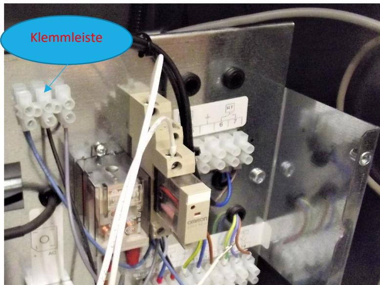
Bild 4: Relais+ Klemmleiste direkt auf Gerät schrauben
