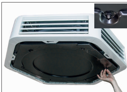
Abb. 34: Steckmutter an Kondensatwanne abschrauben
