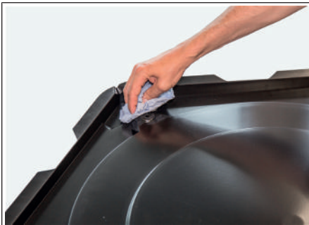
Abb. 36: Kondensatwanne reinigen
