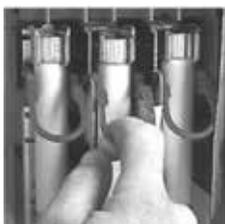
**Extracteurs de fusible intégrés (type 12 et 4x 30–200 A)**
