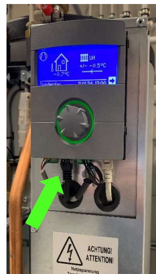
Figuur 8 Regelaar kap verwijderd
