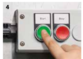
4 Einschalten. Der Motor läuft drehzahlregelt.
