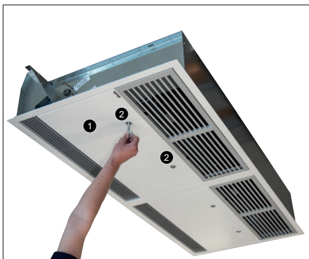
Abb. 33: Revisionsklappe öffnen, Tandem
