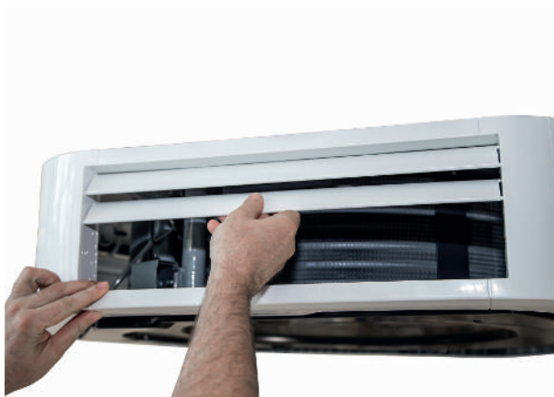
Abb. 32: Lamellen entnehmen
