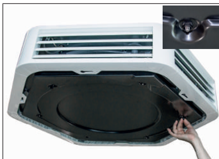
Abb. 34: Steckmutter an Kondensatwanne abschrauben
