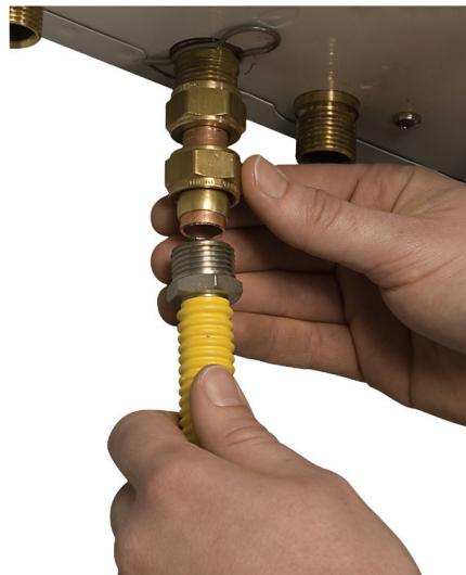
En aan de toevoerzijde van een 3/4" kraankoppeling ten behoeve van de voorgeschreven gaskogelkraan.
