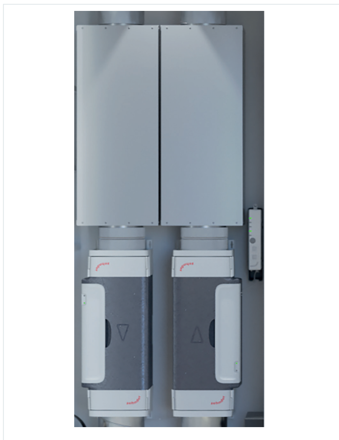
Fig. 2.1 – Caisson de ventilation de l'air ambiant
