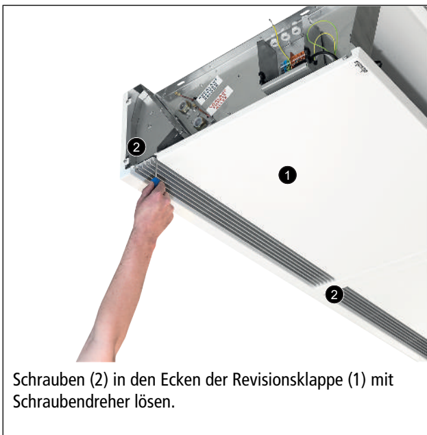
Abb. 32: Revisionsklappe öffnen, Tandem
