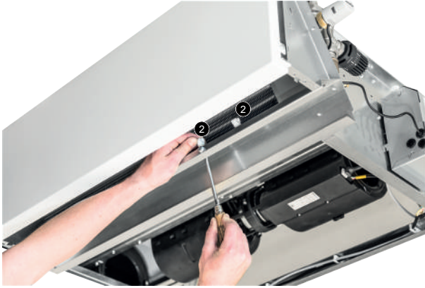
Abb. 18: Rohrclipse ② montieren.
