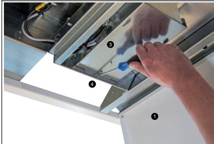
Abb. 15: Sicherungsschraube lösen
