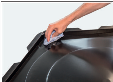
Abb. 35: Kondensatwanne reinigen
