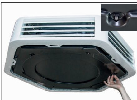
Abb. 33: Steckmutter an Kondensatwanne abschrauben
