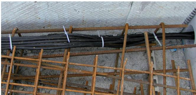
4. Die Heizmatten sind jeweils nach der Auslegung auf Durchgang, Widerstand und Isolationswert zu prüfen, mit dem Widerstandswert auf dem Leistungsschild zu vergleichen und in das Prüfprotokoll einzutragen. Abweichungen von -5 bis +10 % des Sollwertes sind innerhalb des Toleranzbereiches..
