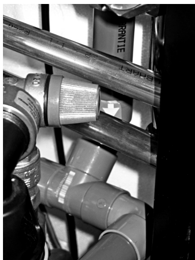
Condensafvoerleiding
