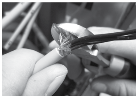
Strip en verkort de buskabel. Let op: afscherming op ca. 6 mm afkorten.
