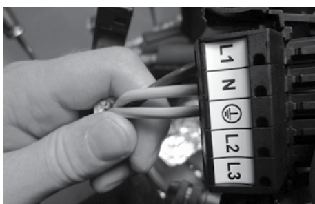
Aangesloten steekcontact 230 V.
