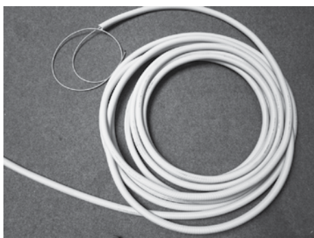
Trek de buskabel met behulp van de trekdraad in de loze leiding.
