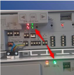
Vous pouvez vérifier si l'accouplement s'est déroulé correctement en créant une demande de chaleur par l'intermédiaire du thermostat et en voyant si le contact de la pompe s'allume à la fois au niveau de la barre de commande et du HCM.
