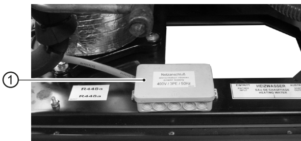
1 Elektrische aansluitdoos: Netaansluiting van de warmtepomp
